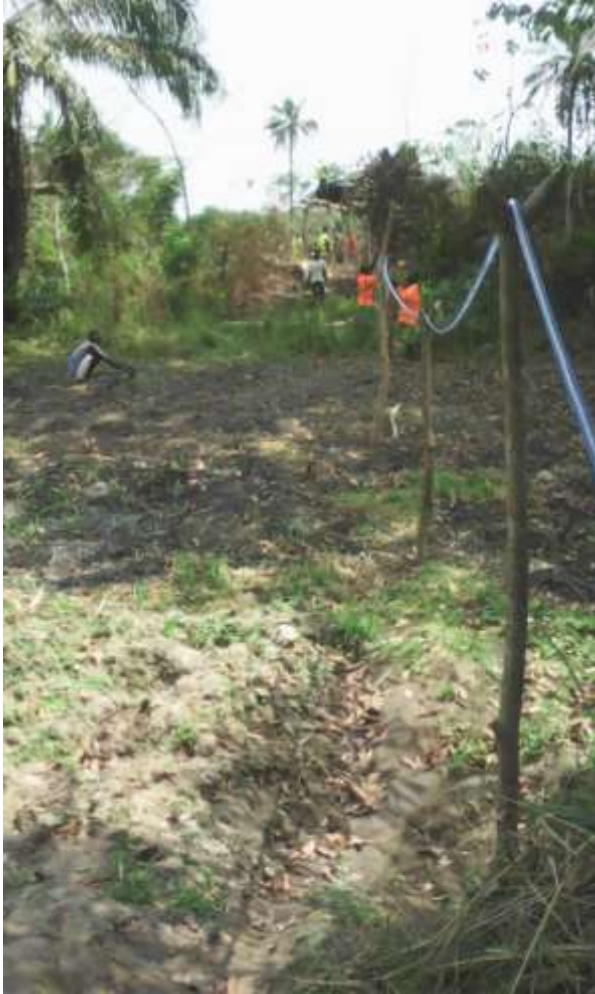
Das Wasser wird in einem Tank gespeichert, von dem aus die Ackerfläche bewässert werden kann.
