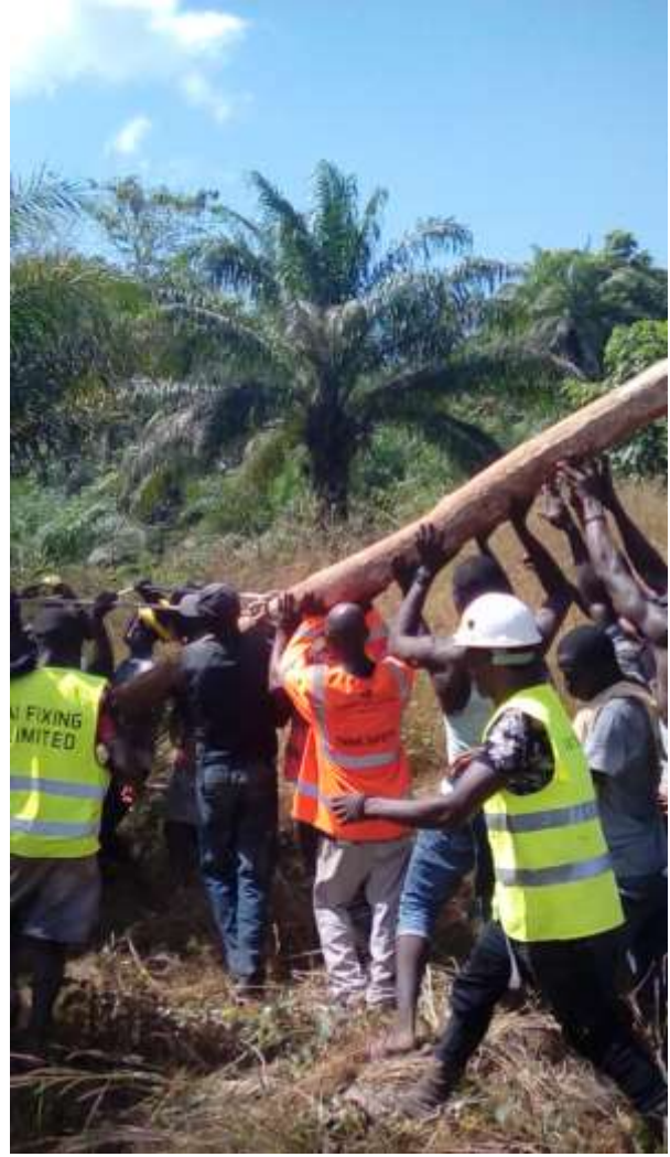
Zu Anfangs wurden Masten aus geschlagenem Holz für die oberirdischen Leitungen errichtet, welche jedoch nach staatlicher Verordnung durch solche aus Metall ersetzt werden mussten.
